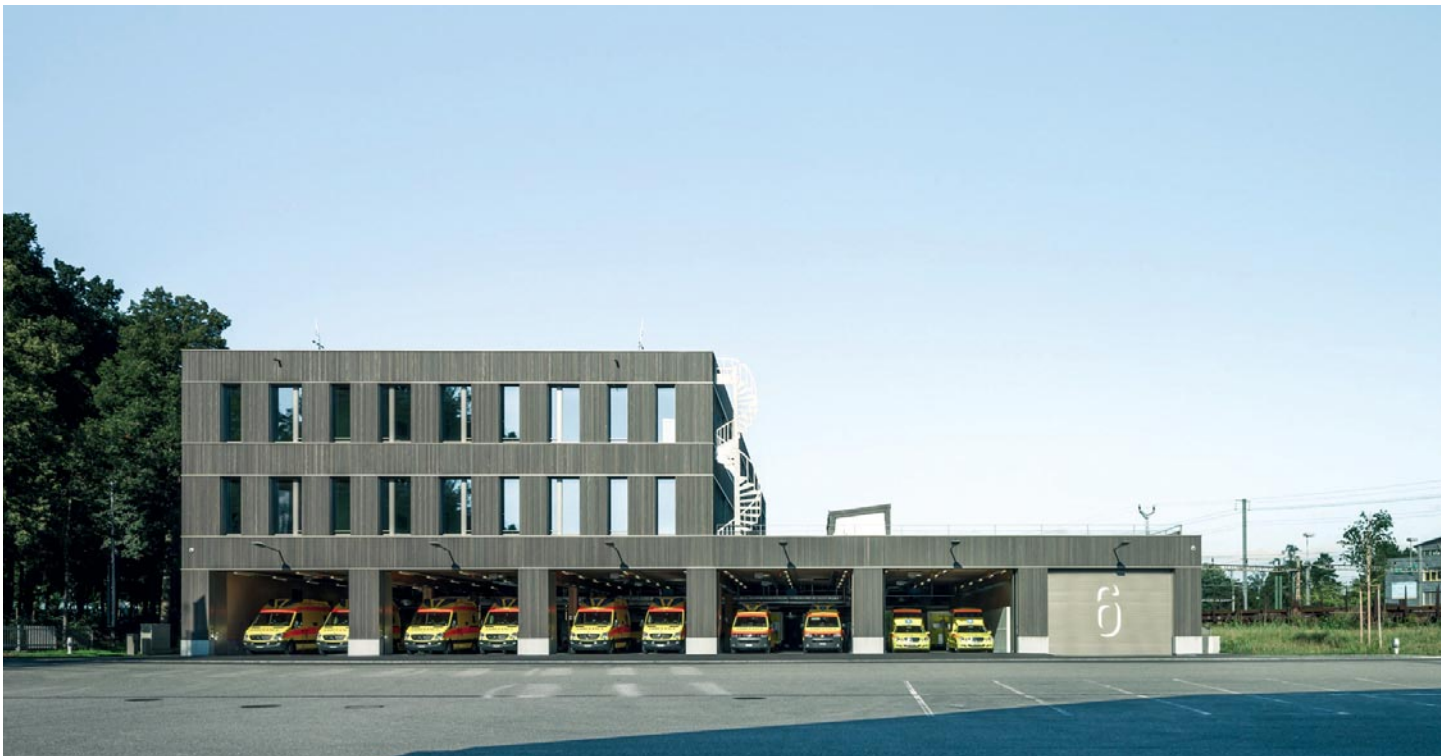
La nouvelle centrale de la police sanitaire est essentiellement composée de bois et répond aux normes Minergie. Le bâtiment peut être surélevé de deux étages, selon les besoins futurs.
